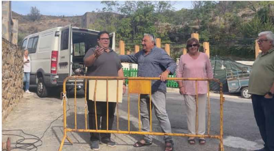
Se van a colocar unos 75 metros lineales de tubería de PVC orientada en Teja | Foto: Gabinete
