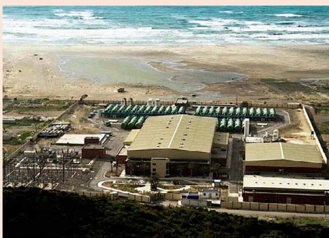
Mostaganem es una planta desaladora de GS Inima en Argelia.
