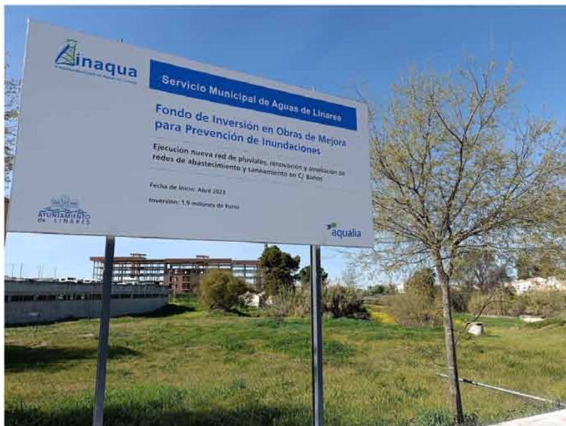
Cartel que anuncia las obras de Linaqua en Linares. / Cadena SER
