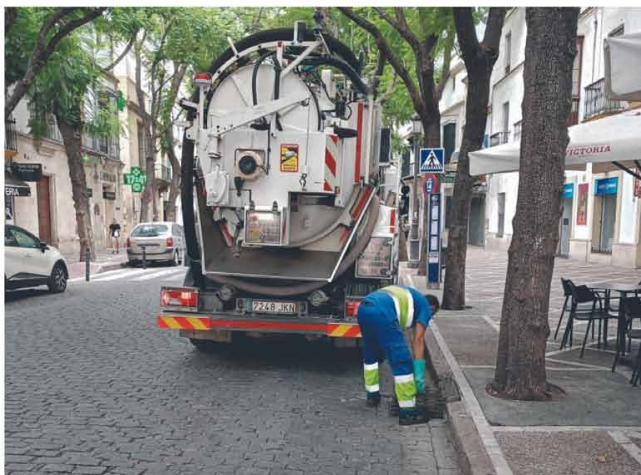
Inspección manual de un imbornal en la céntrica calle Porvera. - Aquajerez
